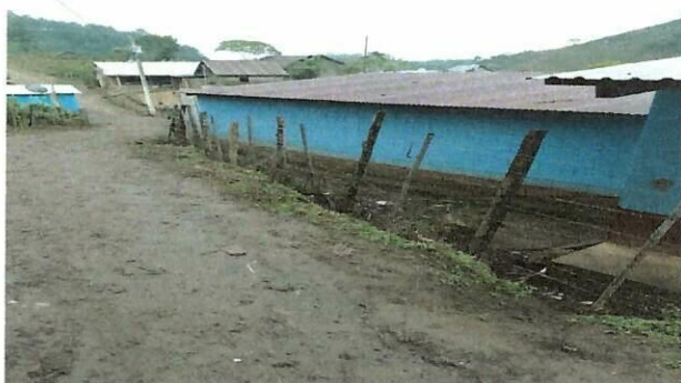
Foto 3: Se realizará mejoramiento del muro perimetral en la parte frontal que se cuenta con buen perimetro de cerco
