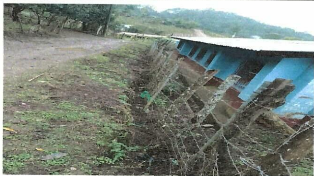
Foto1: Se realizará mejoramiento en el muro perimetral de 5 hileras de block y malla encima en la parte frontal
